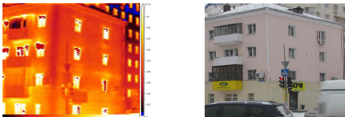
Рис. 6. Термограмма и фотография МКД в г. Тюмень
